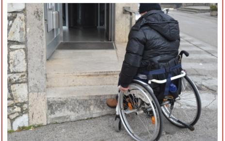
Purtroppo chi si muove in carrozzina da solo, ma anche chi è accompagnato, non può accedere né al bancomat né entrare in banca perché ci sono due enormi gradini che non permettono l'accesso.
